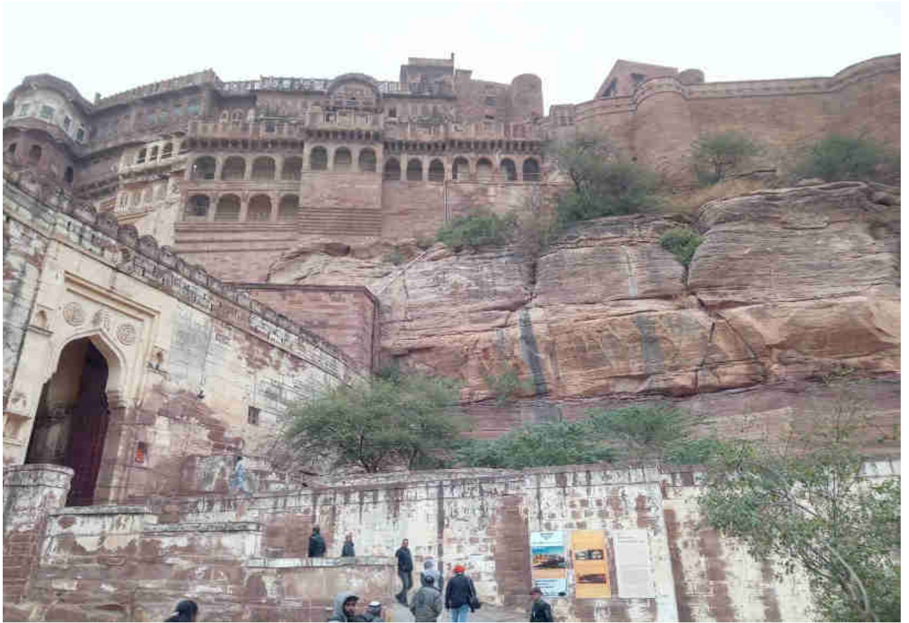
Mehrangarh Fort Jodhpur, Rajasthan 2019-20
